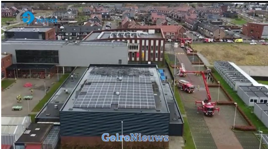
Figuur 18 80% van het dak is bedekt met zonnepanelen (bron: Gelrenieuws)
