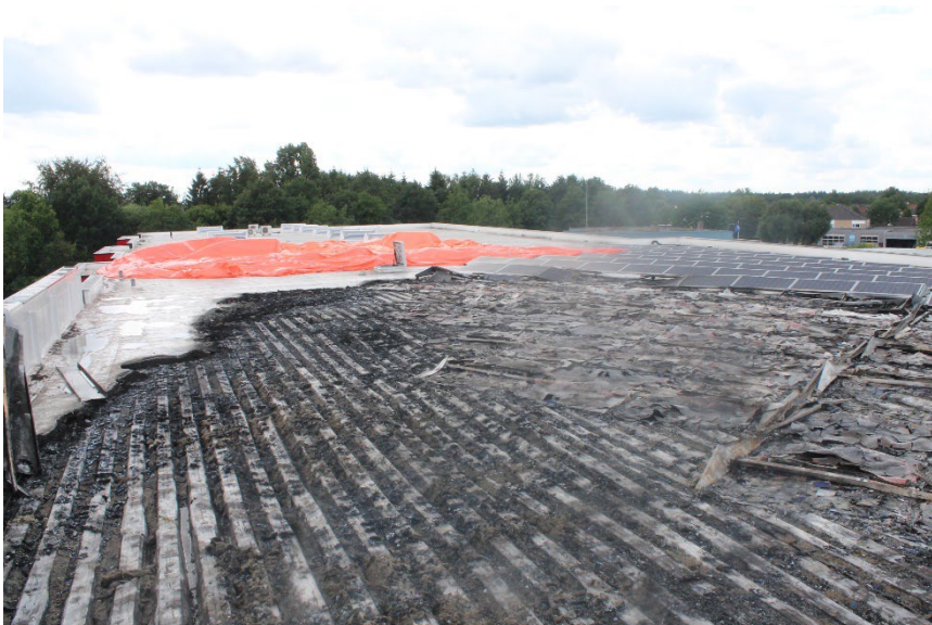
Figuur 4 De brand is tegengehouden voor de brandscheiding (ter plaatse van het zeil op het dak) (bron: Brandweer Twente)
