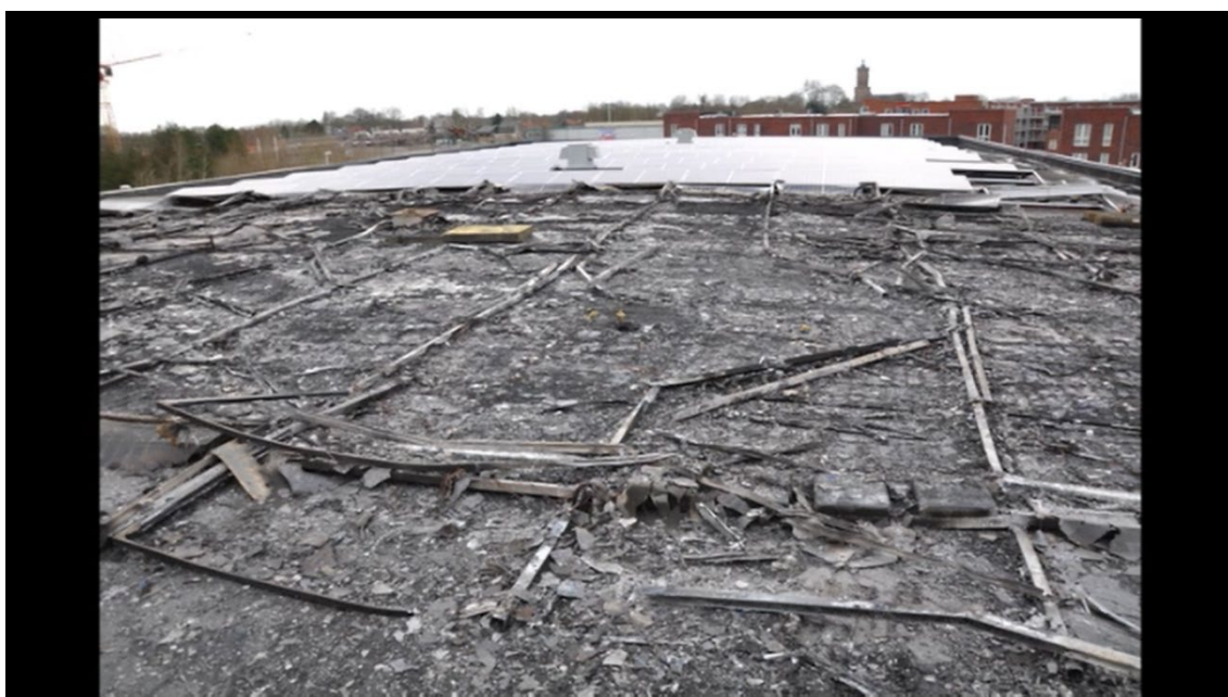
Figuur 20 Schade aan de PV installatie en het dak (Bron: Brandweer Gelderland-Midden)
