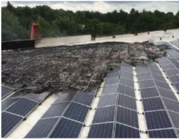
Figuur 2 Overzicht van de schade op het dak (bron: onbekend)
