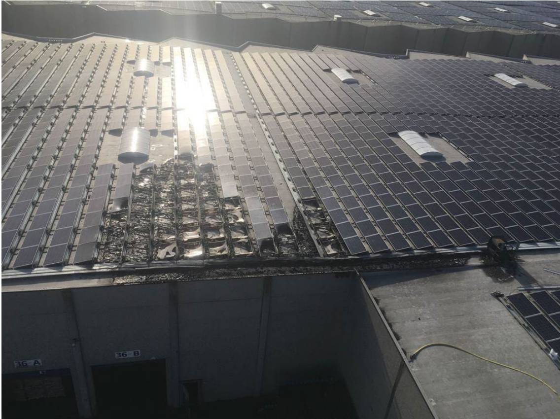
Figuur 9 Schade op het dak van de opslaghal (bron: Brandweer Amsterdam-Amstelland)
