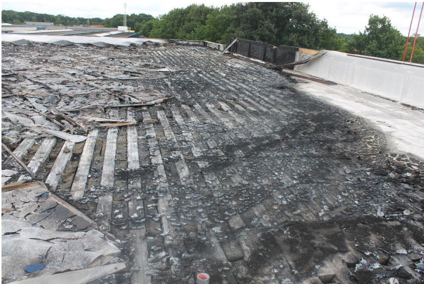
Figuur 3 Schade aan het dak (bron: Brandweer Twente)
