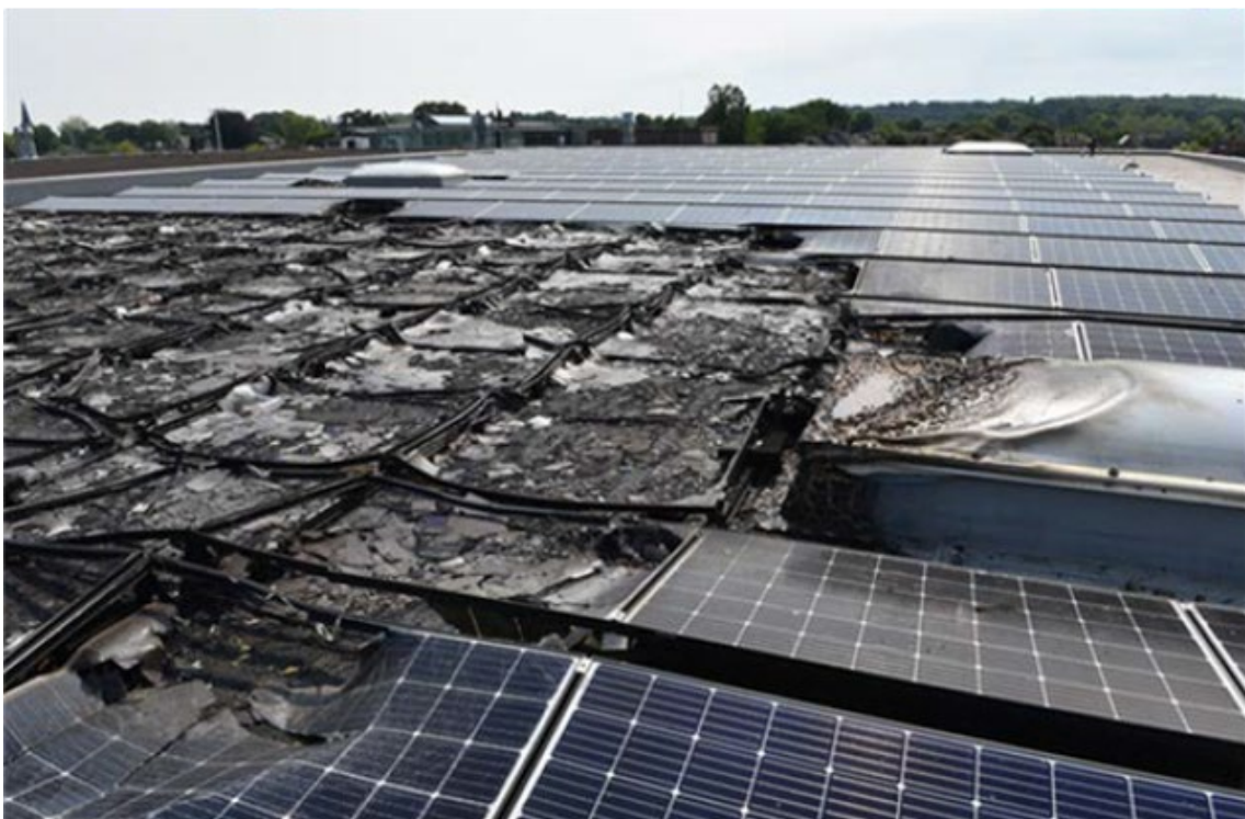
Figuur 12 Schade op dak van Gazelle, waarbij de brand tot aan een daklicht gekomen is (bron: onbekend).
