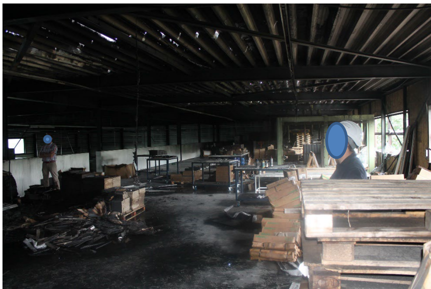
Figuur 6 Secundaire brand in het gebouw door brandend vallend materiaal (bron: Brandweer Twente)
