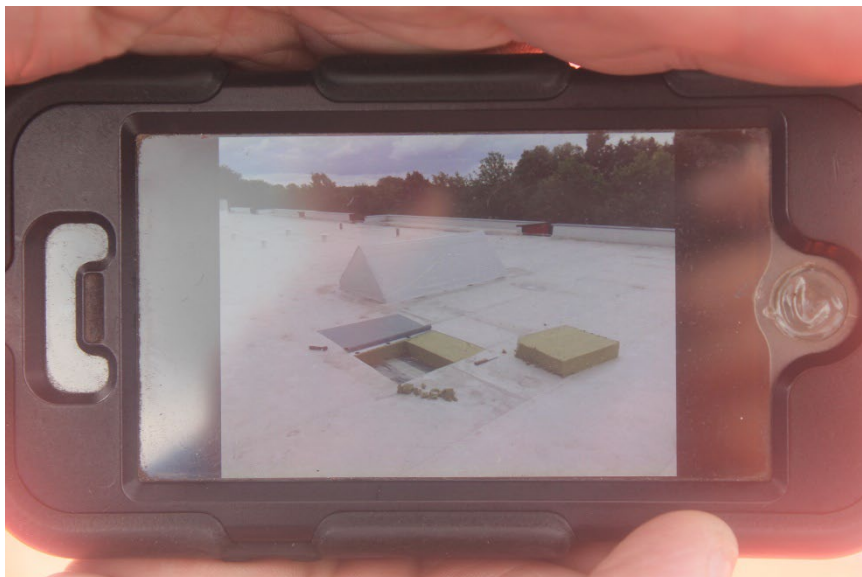
Figuur 5 Het dak is op de brandwerende scheidingen onderbroken met steenwol, maar niet afgedekt met een laag betontegels (bron: Brandweer Twente)
