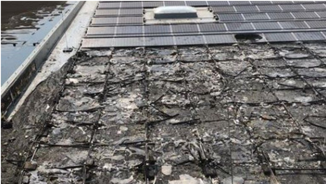
Figuur 11 Schade op het dak van Gazelle (bron: www.omroepgelderland.nl )
