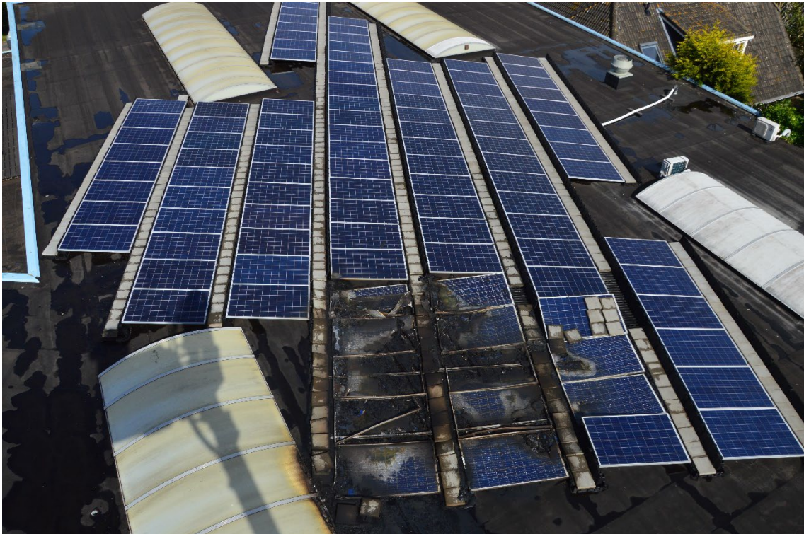
Figuur 14 Schade op het dak (bron: TBO Brandweer Haaglanden)
