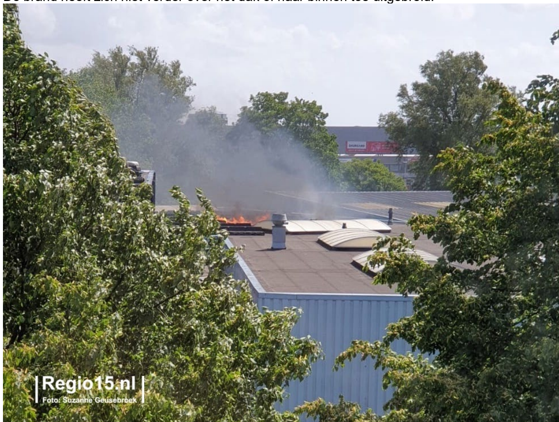
Figuur 13 Brand in de zonnepanelen (bron: Regio15.nl)
