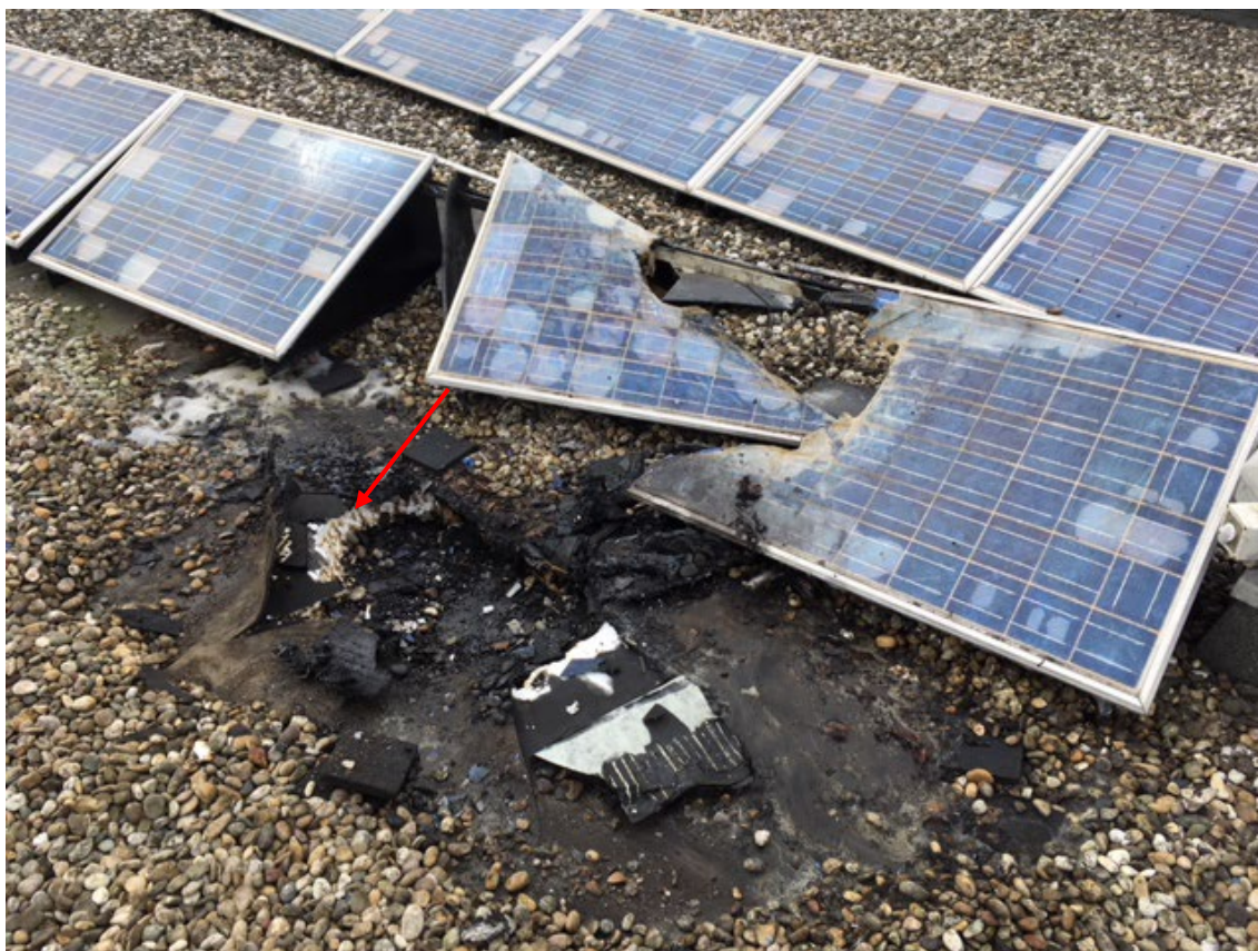
Figuur 8 Schade aan zonnepanelen en dak. Bij de rode pijl is gesmolten EPS zichtbaar in de kenmerkende “gekarameliseerde druppels” (bron: Gemeente Opmeer)
