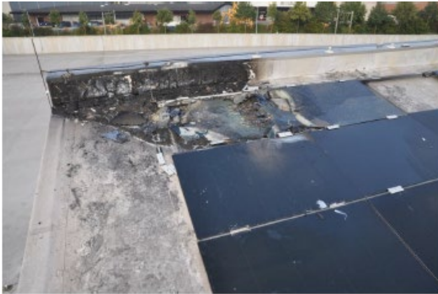
Figuur 17 Brandschade beperkt tot enkele panelen en een klein deel van het dak.
